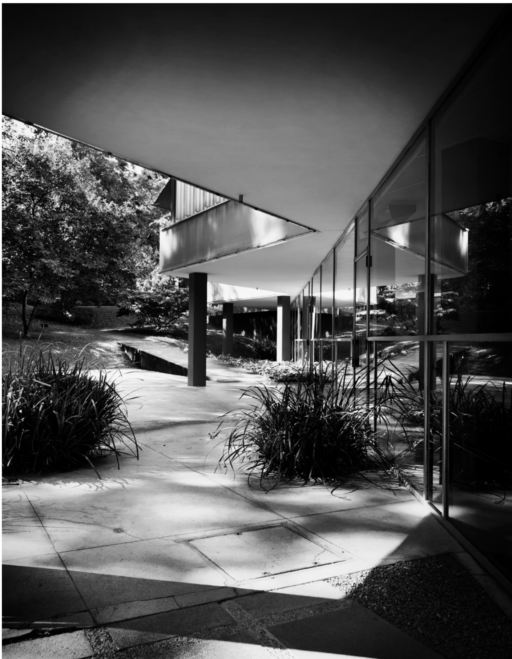
Marc-Joseph Saugey, immeuble de logements Miremont-le-Crêt, Genève. Jardin d'entrée excavé. Photo: pour Faces, © Inès d'Orey.
