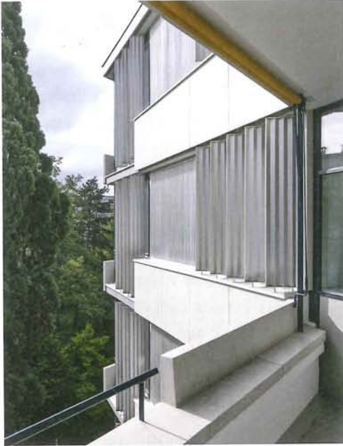
Sichtblenden aus Aluminium schützen die Privatsphäre benachbarter Wohnungen. Sie wurden nur gereinigt und wieder eingebaut.
