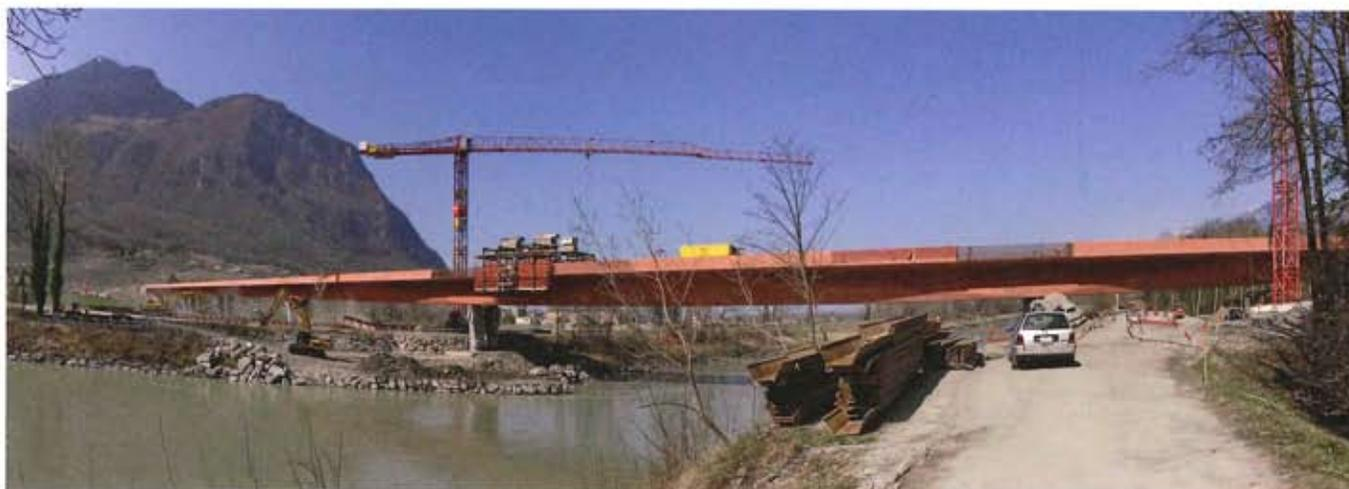
Fig. 1 : Le viaduc sur le Rhône avec les chariots pour le bétonnage des parapets (Photo Jean Jeker)
