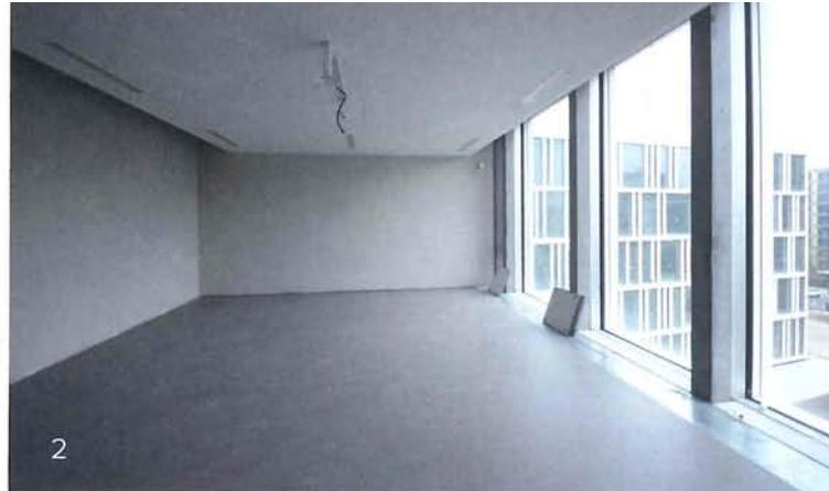
Sur ce secteur, les poteaux de façade font office de tirants et ramènent les efforts de portée jusqu'à la dalle de toiture fortement précontrainte. Cet impératif technique complique quelque peu le planning, les dalles intermédiaires ne pouvant être décoffrées et les étais supprimés qu'au moment où la charge finale est libérée dans la dalle de toiture. La position des étais a fait l'objet d'une étude détaillée afin de permettre néanmoins l'avancement des installations techniques au plafond.
